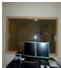
Διαμόρφωση χώρου στο υπόγειο της Νέας Πτέρυγας για την εγκατάσταση νέου Αξονικού Τομογράφου.
