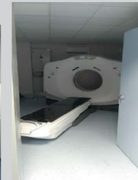
Διαμόρφωση-ανακαίνιση τμήματος εγκατάστασης νέου Αξονικού Τομογράφου (εξομοιωτής).
