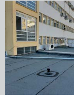
Αντικατάσταση μόνωσης δώματος του χώρου πλυντηρίων.
