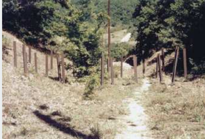
Σιδηροδροκοί φράσσουν το δρομολόγιο. (φωτογρ. Σχης Γ. Καραμπατσόλης).
