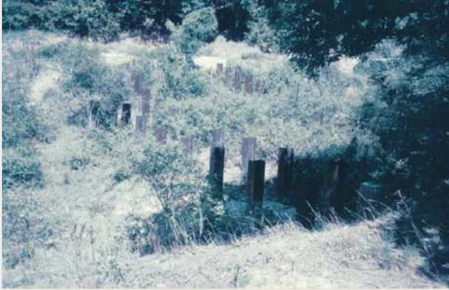
Εμπόδια με σιδηροδοκούς κοντά στη χαράδρα. (φωτογρ. Σχης Γ. Καραμπατσόλης).
