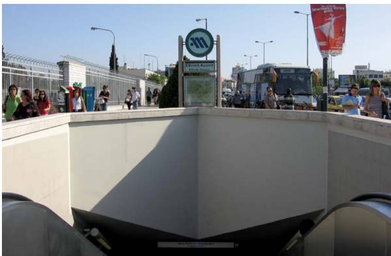
Είσοδος του μετρό της Αθήνας στον σταθμό «Εθνική Άμυνα».
