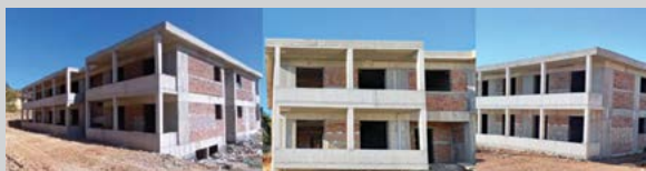
Κατασκευή 13 διαμερισμάτων ΣΟΑ, στο Στρατόπεδο «ΚΑΡΑΪΣΚΑΚΗ» (σε εξέλιξη).
