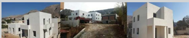
Κατασκευή 8 διαμερισμάτων ΣΟΑ-ΣΟΜΥ, στη ν. ΚΑΛΥΜΝΟ (σε εξέλιξη).
