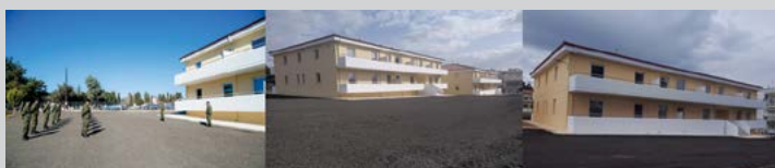
Κατασκευή 26 διαμερισμάτων στο ΣΟΕΠΟΠ Στρατόπεδο «ΠΑΤΣΟΥΚΑ», στην Αλεξανδρούπολη.
