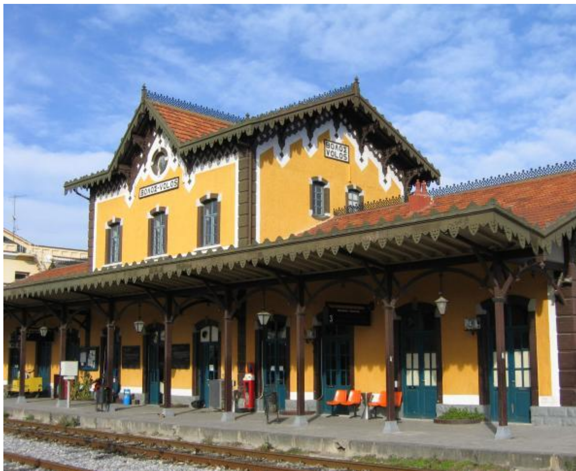
Σιδηροδρομικός Σταθμός Βόλου
