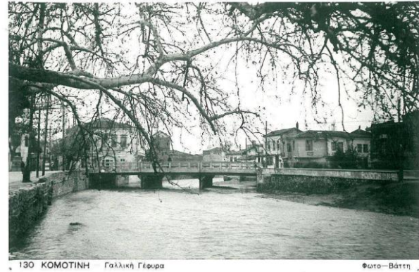
130 ΚΟΜΟΤΙΝΗ Γαλλική Γέφυρα
